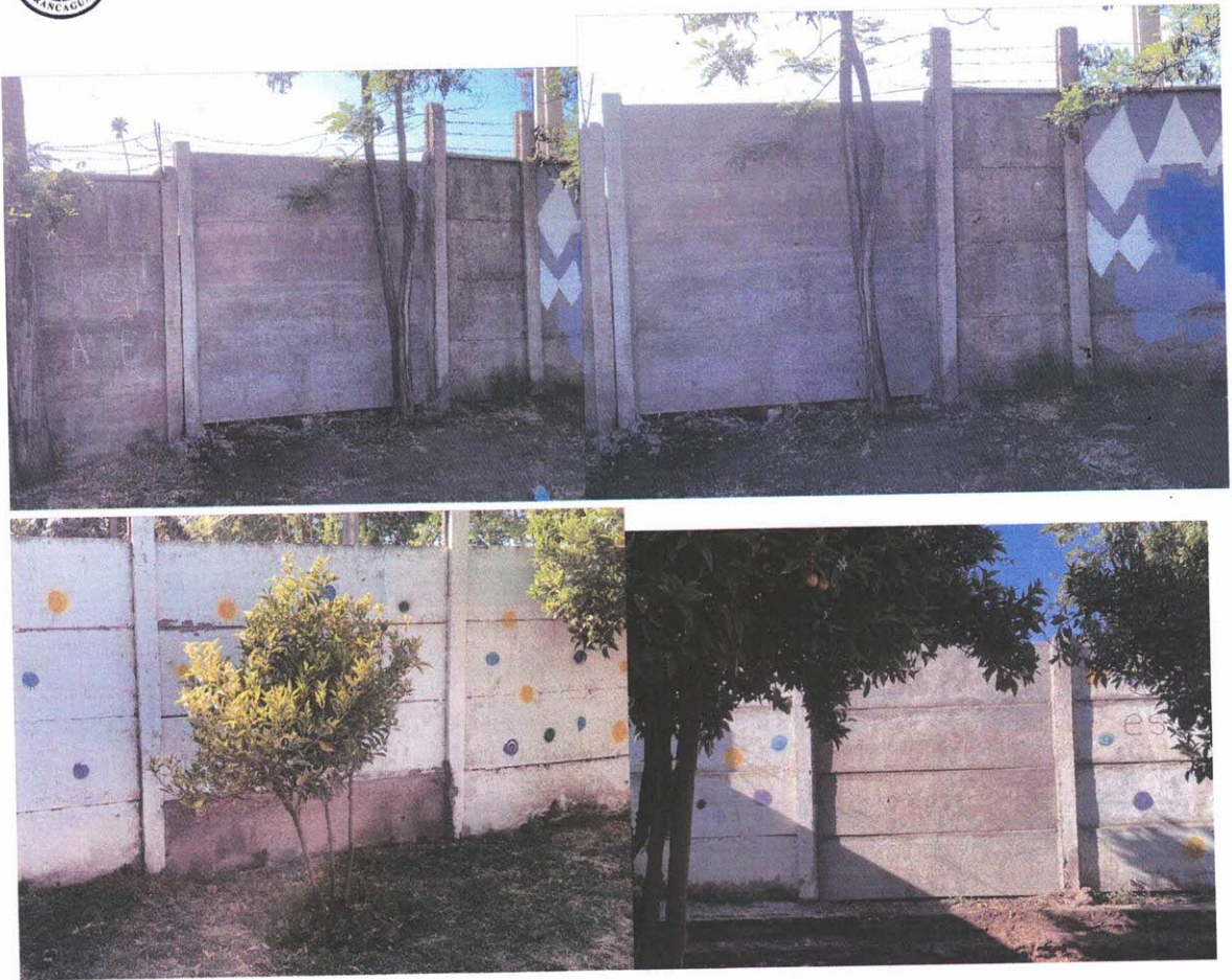
Panderetas cambiadas en Patio central, cancha, patio de la virgen y estacionamiento directivo.
